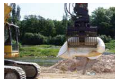
Einbau mit Hilfe eines Baggers o. Ä.
