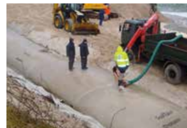
Befüllung der Schläuche (Saugbagger, Schlammpumpe)
