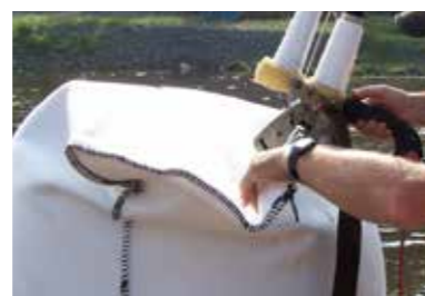
Verschluss der Säcke mittels Handnähmaschine
