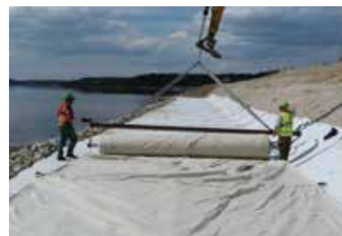
Auslage der Schläuche (z. B. mit unserer Verlegehilfe)
