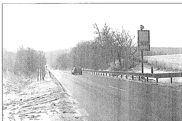
Abbildung 11 Bundesstraße B 180 unter Betrieb: vorne ein Warn-Stopp-Schild, weiter hinten der gesicherte Bereich
