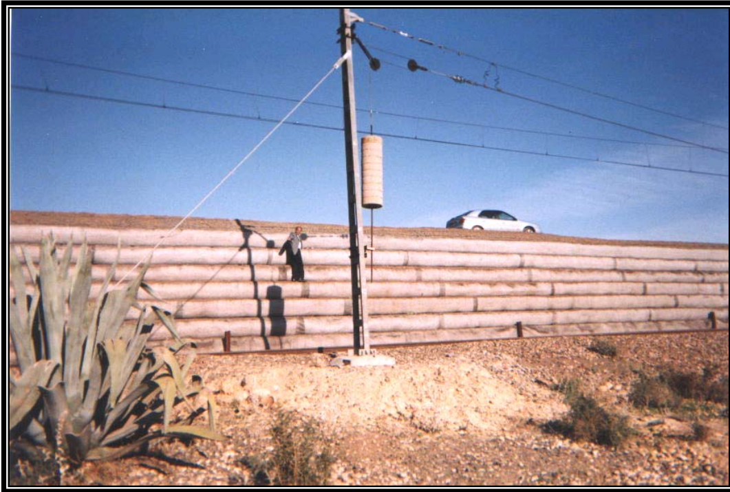
Photo 5 et 6 : Vue d'ensemble du projet de 400 m de long
