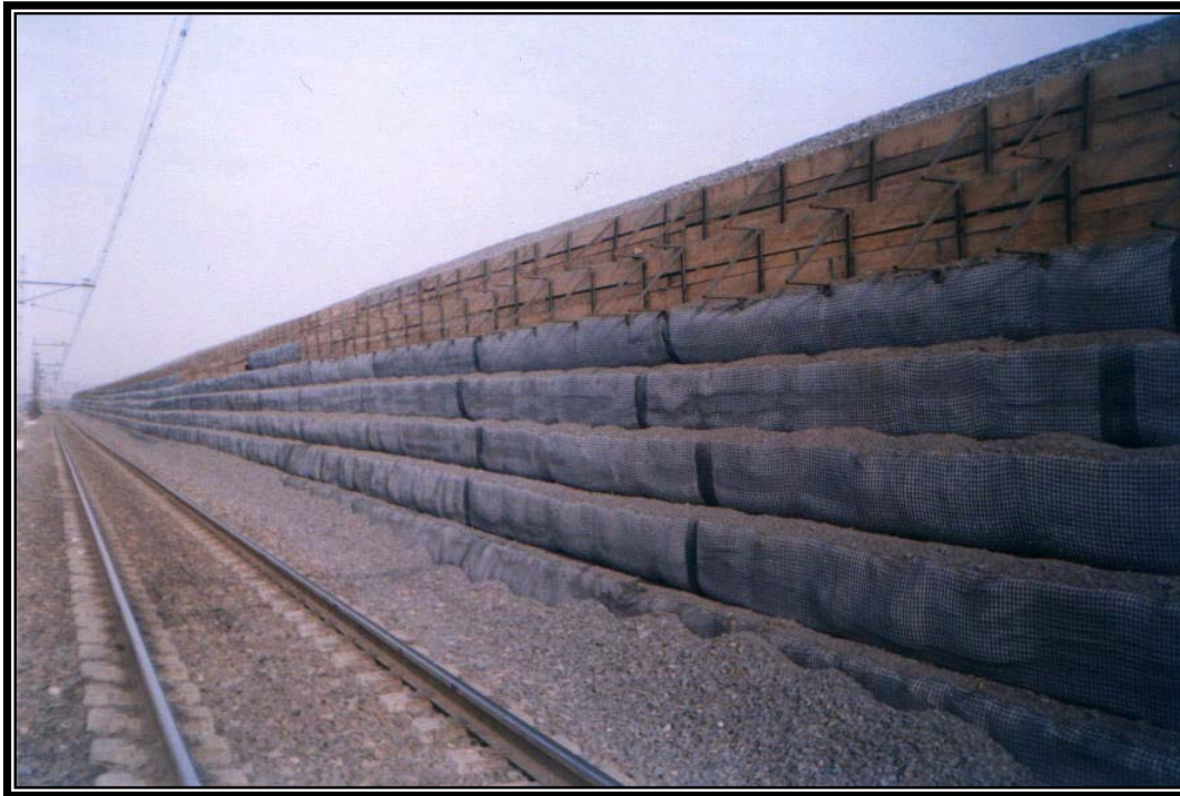
Photo 2 :Vue sur le coffrage permettant de monter le mur de soutènement
