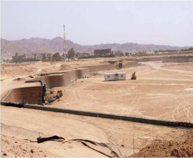
Abbildung 2.1 Fertiggestellte Lagunenumrandung mit unregelmäßigem Grundriss
