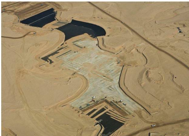
Abbildung 2.2.1 Luftbildaufnahme - Verlegte Abdichtung mit teilweiser Betonüberdeckung
