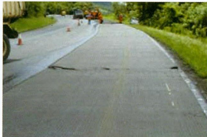
Figura 10 Instalação da geogrelha
