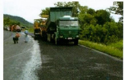
Figura 11 Espalhamento da camada de concreto betuminoso usinado a quente
