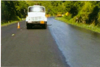
Figura 9 Camada de reperfilagem executada sobre o pavimento antigo (acima) e execução da pintura de ligação (abaixo)
