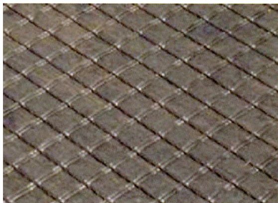
Figura 8 Detalhe da geogrelha de poliéster já instalada no campo
