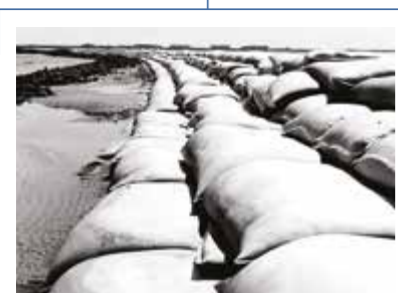
1963 Rüstersieler Watt Deutschland Deichbau SoilTain® Bags
