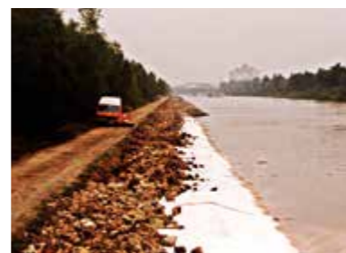
1989 Mittellandkanal Deutschland Deckwerk HaTe® Vliesstoffe
