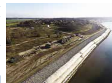
2016 Sedlitzer See Deutschland Kliffsicherung SoilTain® Tubes
