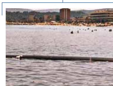
2002 Le Lavandou Frankreich Wellenbrecher SoilTain® Tubes
