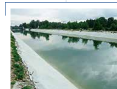
2013 Mittlere-Isar-Kanal Deutschland Kanalsanierung Incomat® Standard
