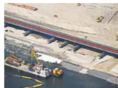
2008 JadeWeserPort Deutschland Deckwerk HaTe® Vliesstoffe Tektoseal® Sandmatte
