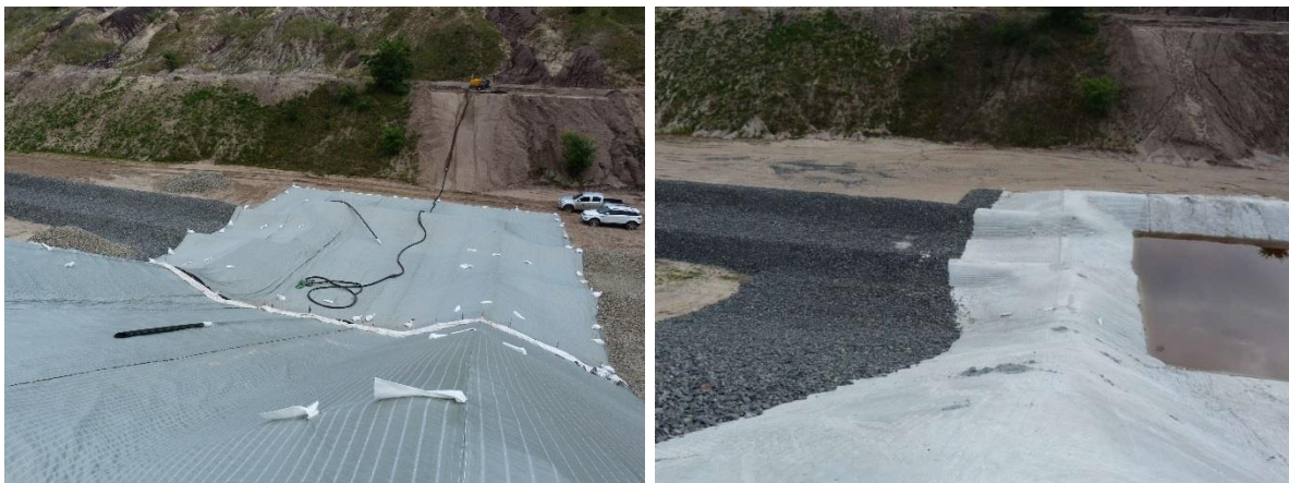
Abbildung 6: Tosbecken (links: unbefüllter Zustand; rechts: linker Auslaufbereich im befüllten Zustand)
