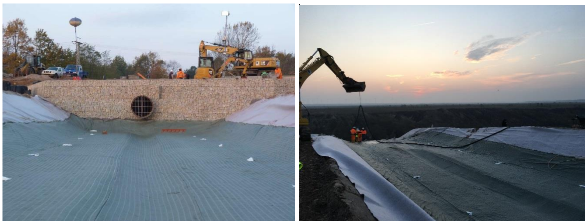
Abbildung 4: Dauerhaftes Einlaufbauwerk während des Einbaus (links: oberwasserseitiger Teil; rechts: Übergang zur Böschung)
