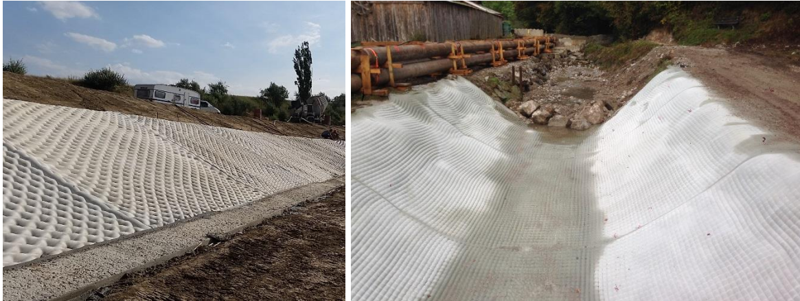
Abbildung 2: Geotextile Betonmatten, exemplarisch (links: mit Filterpunkten; rechts: ohne Filterpunkte)
