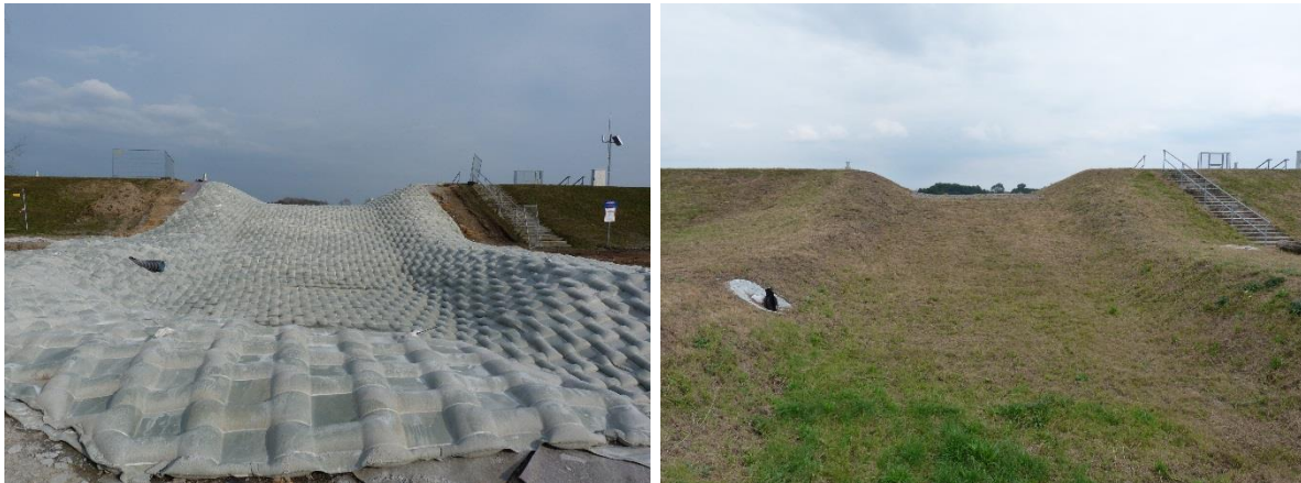
Abbildung 8: Erosionssicherung von Überströmstrecken (links: Einbauzustand; rechts: nach Begrünung)
