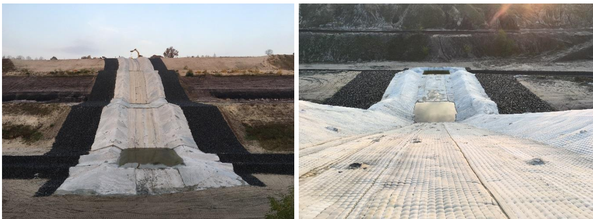
Abbildung 5: Temporäres Einlaufbauwerk (links: Ansicht von der Sohle; rechts: Blick in Fließrichtung von der oberen Berme)
