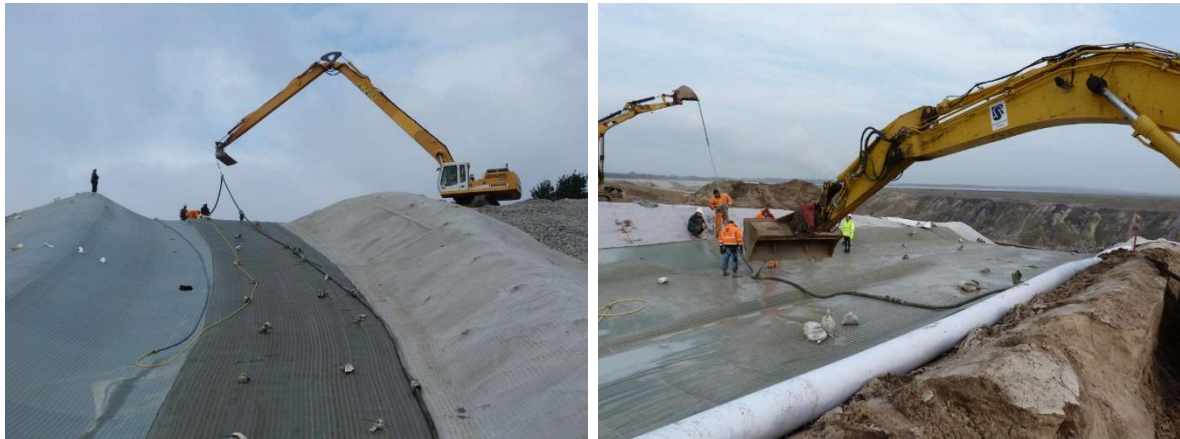
Abbildung 7: Einbau Böschungsbereiche sowie dauerhaftes Einlaufbauwerk (links: Böschungsbereich; rechts: dauerhaftes Bauwerk)
