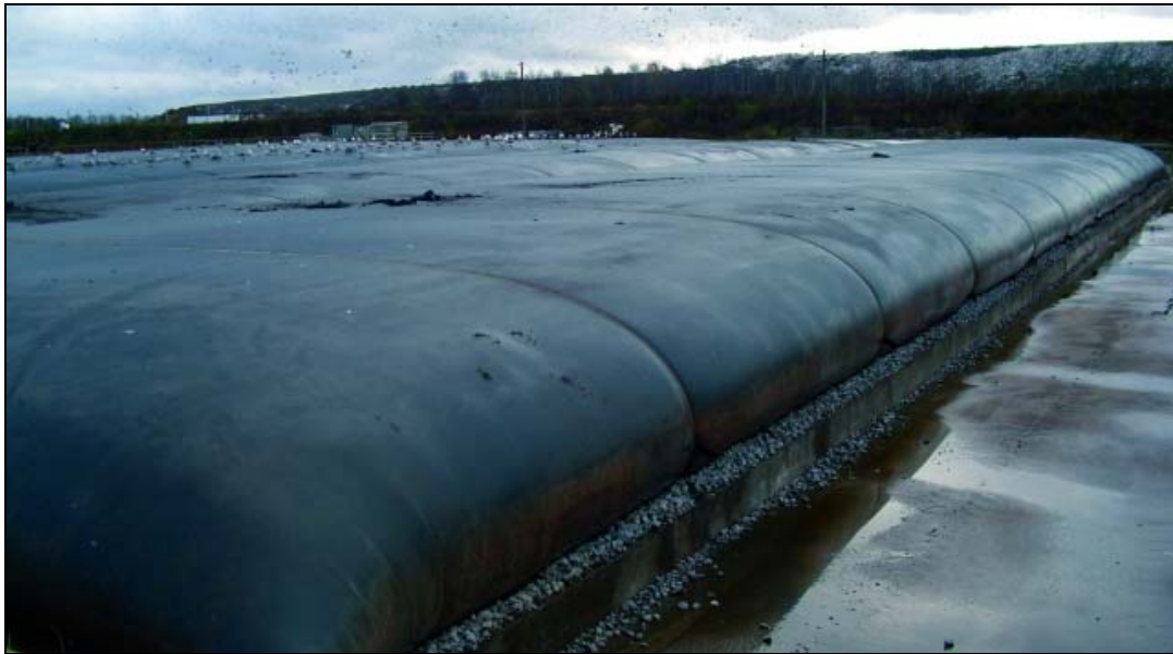
Abbildung 10: Befüllte Entwässerungsschläuche; im Hintergrund die Deponie
