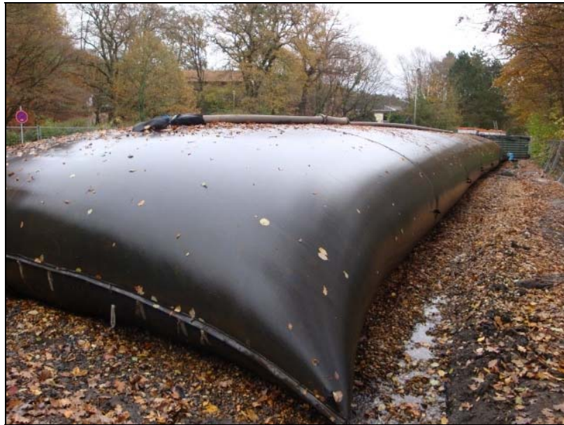
Abbildung 1: Entwässerungsschlauch nach Beendigung der Befüllung (Umfang U = 15 m)
