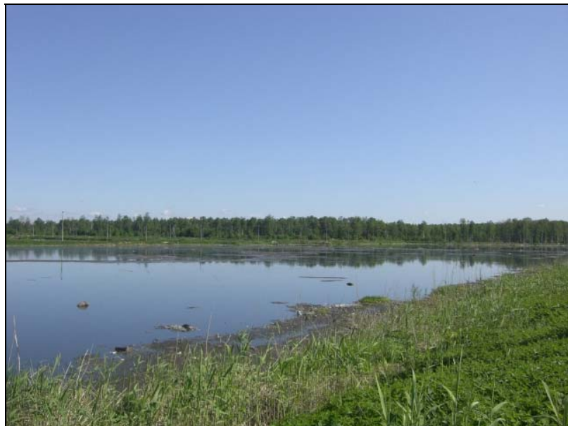
Abbildung 9: Ansicht einer der existierenden bis zu 18 m tiefen Lagunen vor Beginn der Räumungskampagne
