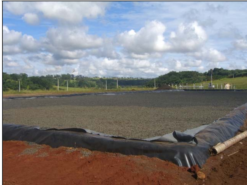
Abbildung 6: Zur Aufnahme der Entwässerungsschläuche vorbereitete temporäre Entwässerungsfläche mit Randdamm, Kunststoffdichtungsbahn, Schutzvliesstoff und Drainageschicht
