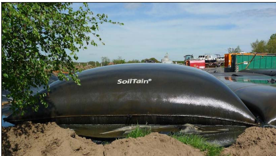
Abbildung 11: Entwässerung des Hafensedimentes
