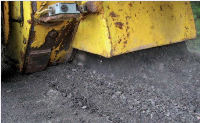
Figura 6 - La fresatura degli strati bituminosi e della geogriglia di rinforzo
