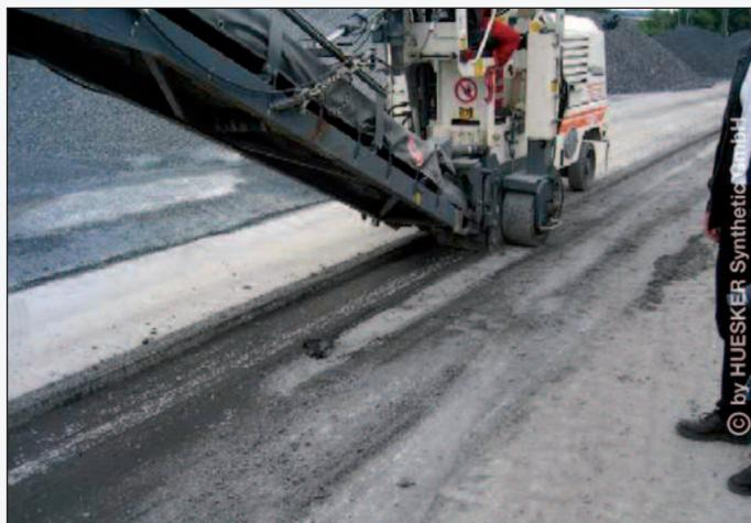
Figura 2 - La fresatura dello strato di conglomerato bituminoso rinforzato con l'HaTelit®
