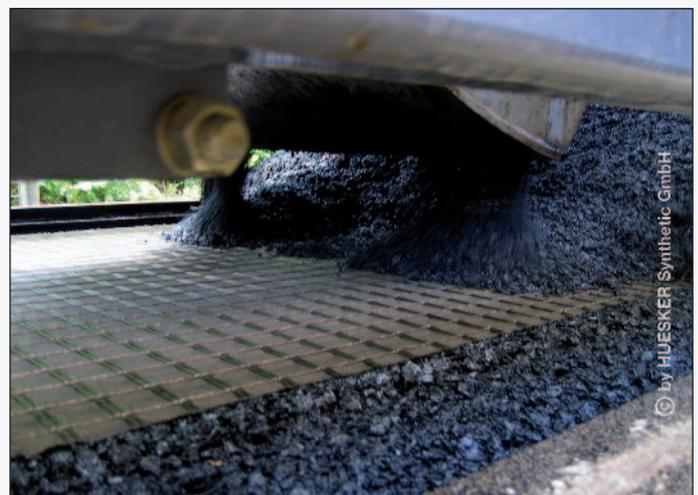
Figura 5 - La posa del tappeto di usura al di sopra dell'HaTelit®
